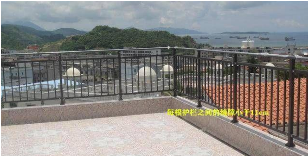
图A12-1 防护栏杆构造示意图
