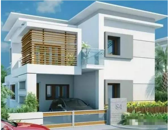
格栅遮阳设施
