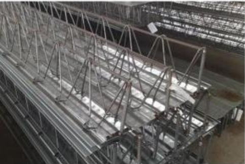
钢筋桁架楼承板
