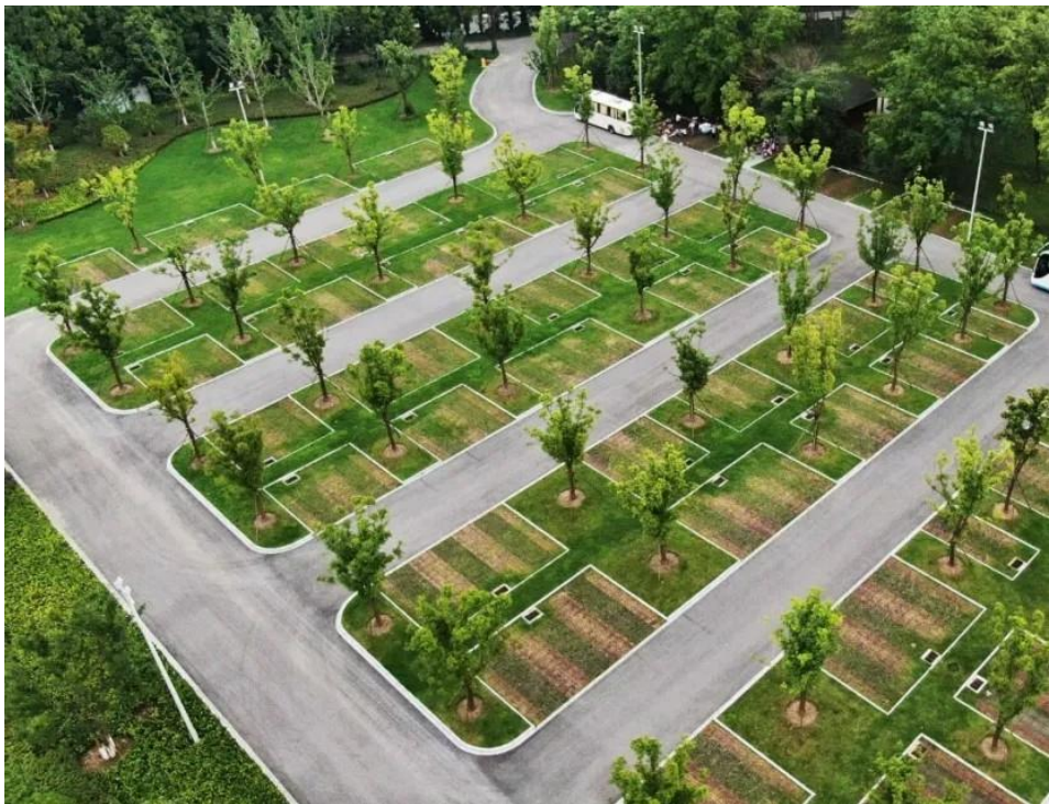
图E3-2 停车场透水性铺装
