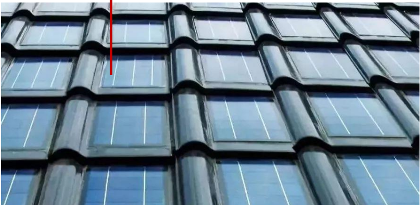
坡屋面采用太阳能光伏瓦
