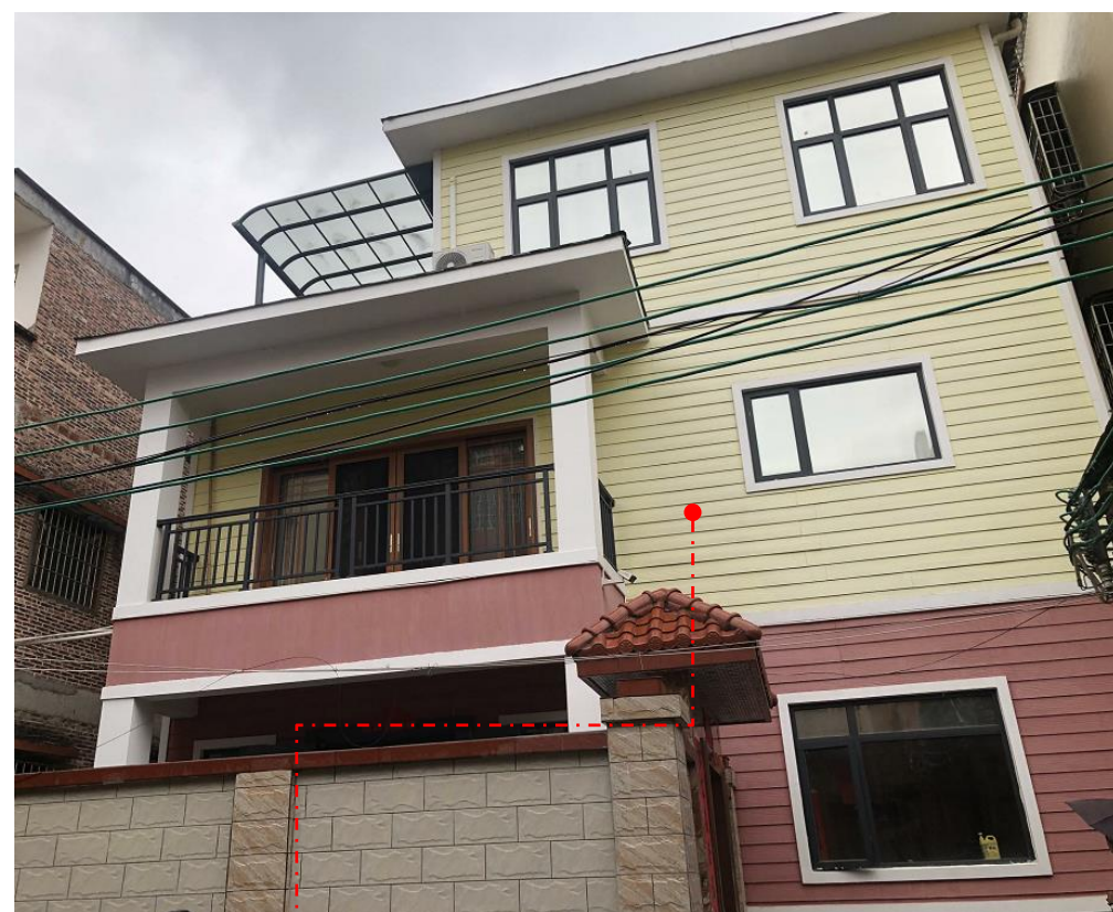
装配式钢结构住房
