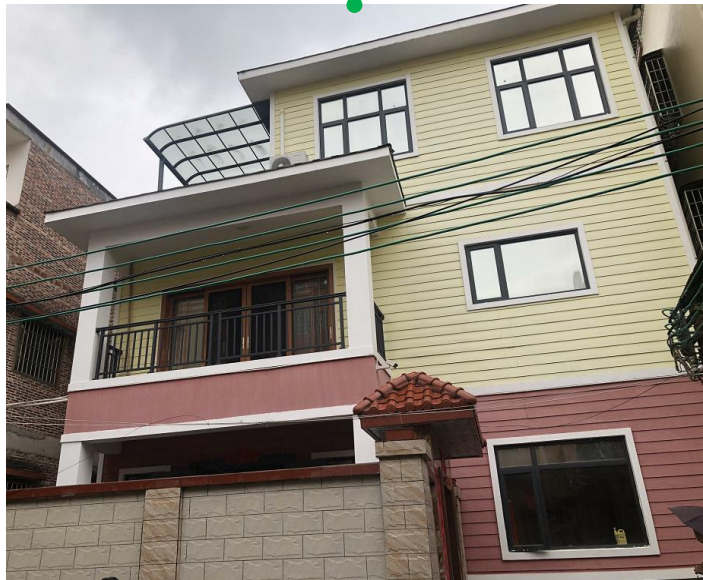
装配式钢结构住房
