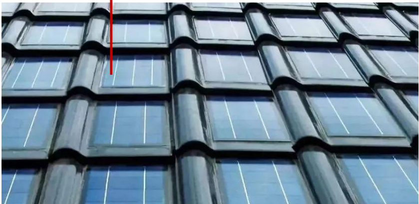
坡屋面采用太阳能光伏瓦
