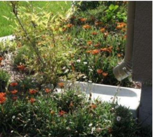
屋面雨水断接
