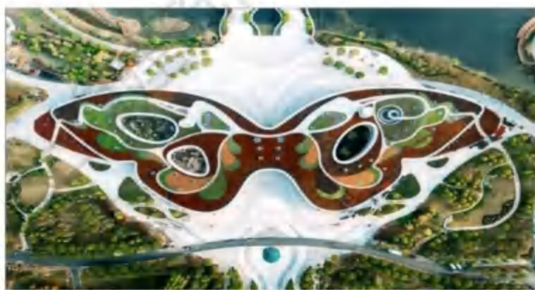
图 2-25 “蝴蝶翅膀”创新采用自由曲面预应力混凝土薄壳结构
