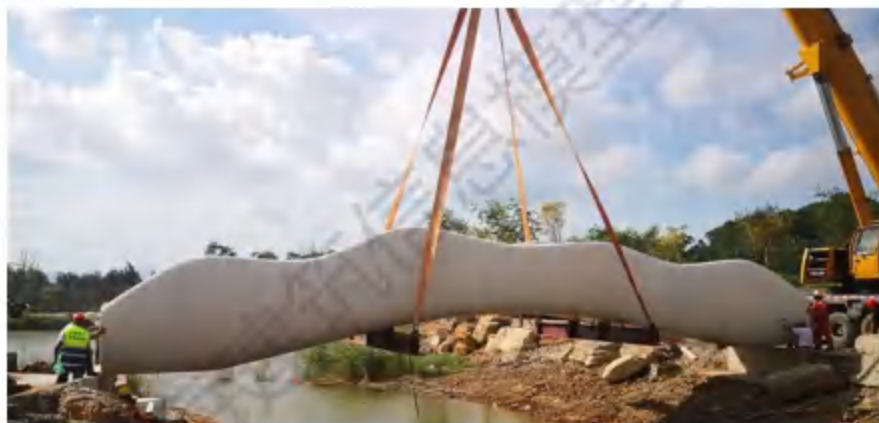
图 3-11 国内最长 3D 打印景观桥施工中
